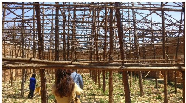
Die Dining-Hall hat über eine für unsere Augen abenteuerliche Gerüstkonstruktion die geschweißten Stahlträger erhalten, auf denen später eine Lattung angebracht wird. Darauf werden dann die Blechplatten montiert. Insgesamt braucht man 400 Platten, Makete hat die Zahlung von 100 zugesagt, allerdings fehlt noch das okay des lokalen Abgeordneten in Dodoma (Man ist zuversichtlich, bald ist allgemeine Wahl – für Regierung in Dodoma und für alle kommunalen Politiker!)
