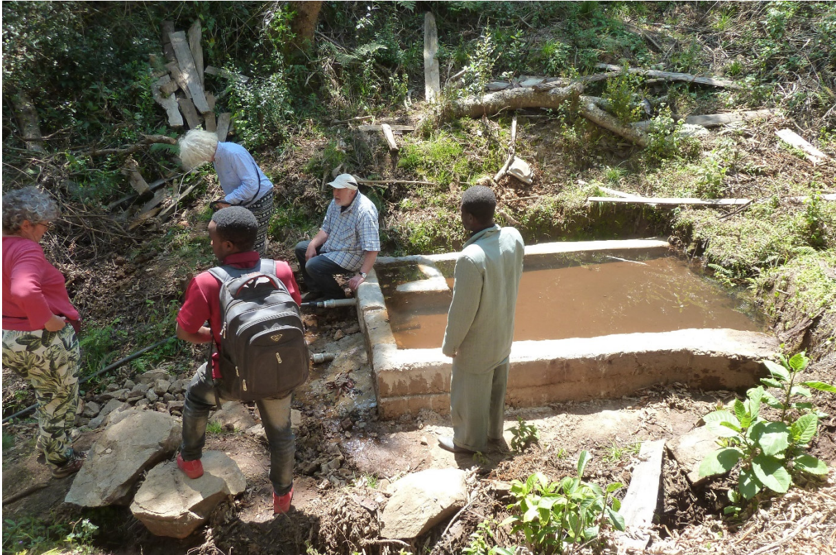
Intake für die Wasserversorgung in Ilungu
