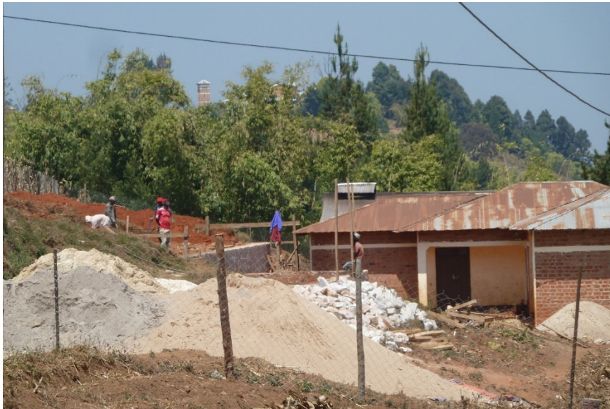
Bau des Speisesaals
